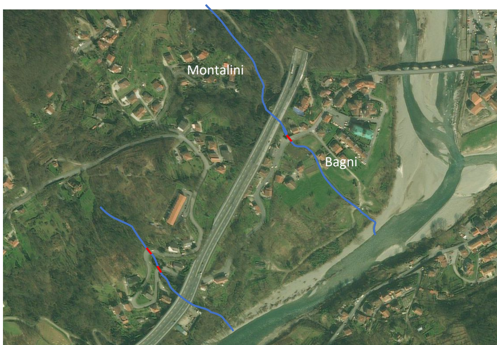
Fig. 2.1 Bagni di Podenzana: in azzurro i principali canali/rii che attraversano l'abitato. In rosso tratteggiato i tratti tombati.
