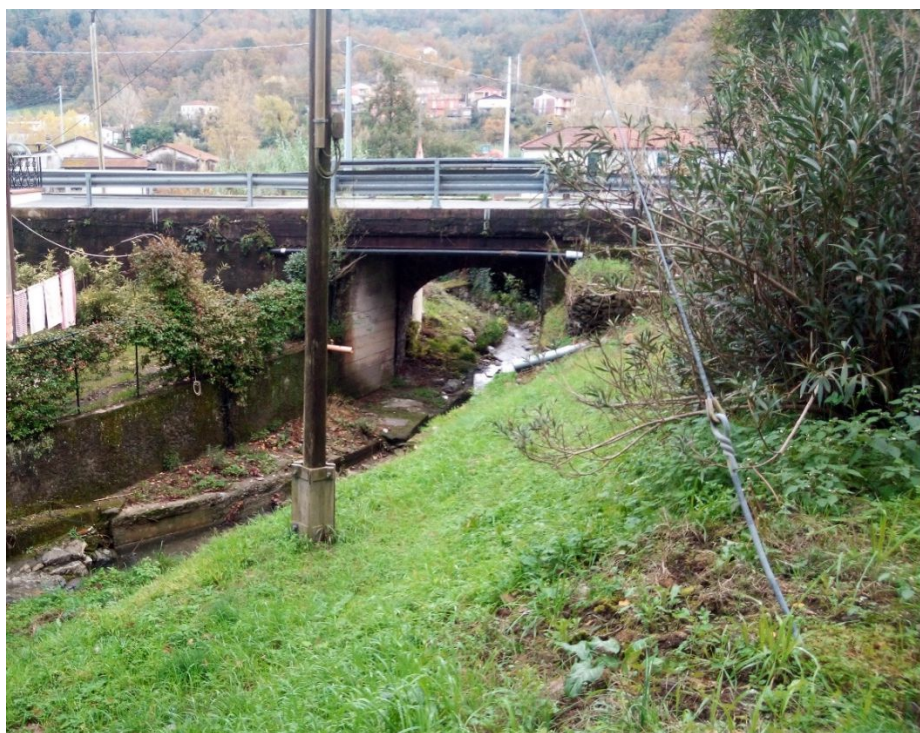
Fig.3.1 Rio Calcinara: tombatura di attraversamento sotto la strada provinciale
